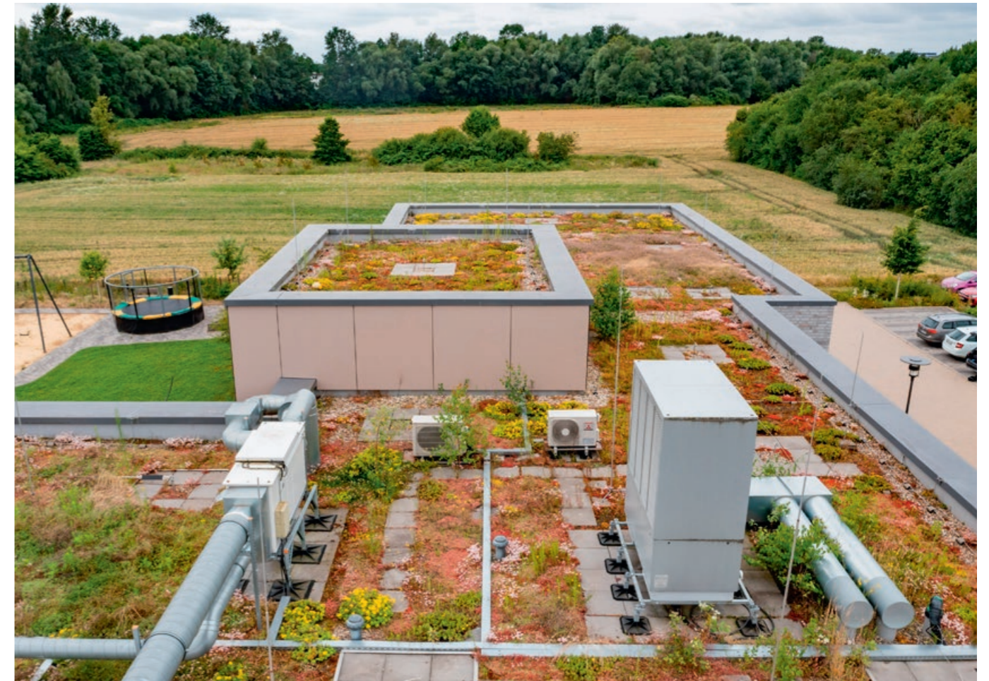
Dach der Tagesklinik mit der Wärmepumpe
