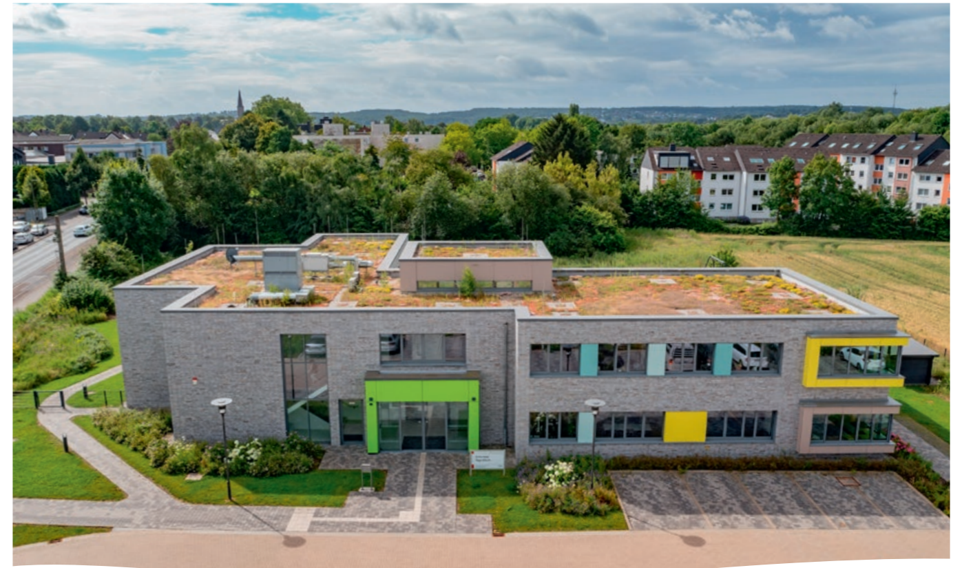
Tagesklinik mit Blick auf die Dachbegrünung
